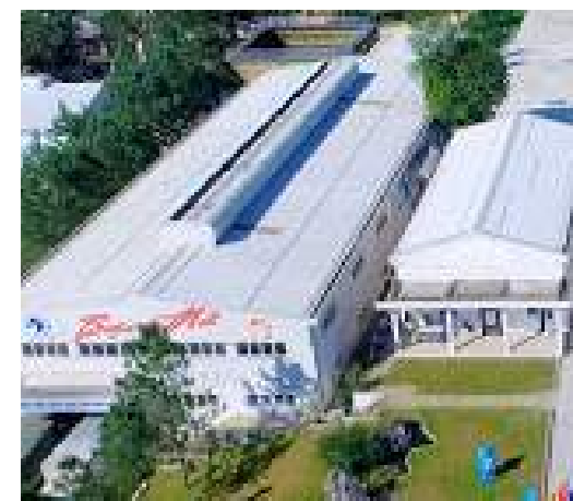
Nhà máy nước sạch Huế.
