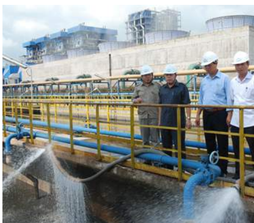
Dự án xây dựng hệ thống cấp nước sạch tại địa bàn tỉnh Ninh Bình.
