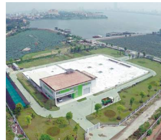
Dự án nhà máy xử lý nước thải Hồ Tây (giai đoạn 2).
