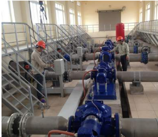
Dự án cung cấp vật tư, thi công lắp đặt hoàn thiện hệ thống nước sạch Vĩnh Phúc.
