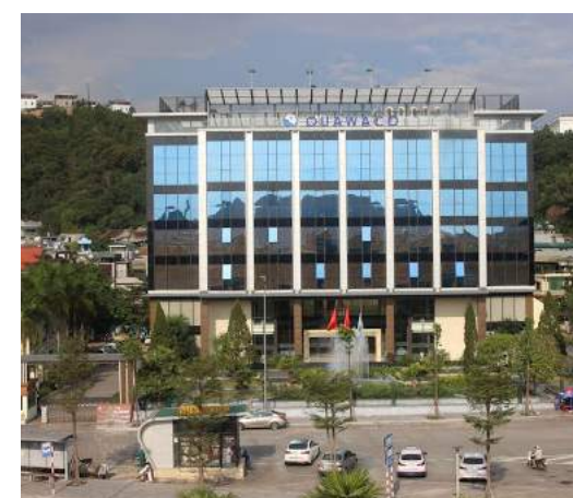
Nhà máy nước sạch Quảng Ninh.
