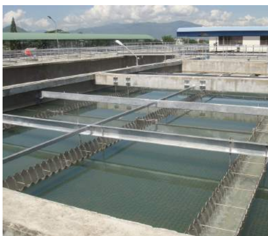
Dự án xây dựng hệ thống cấp nước sạch tại địa bàn tỉnh Thái Nguyên.
