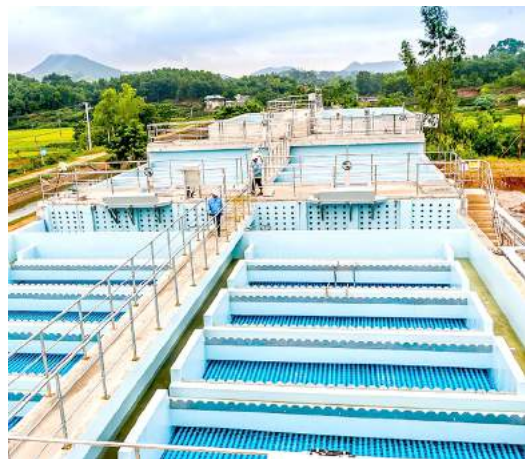
Nhà máy nước Yên Bình và hệ thống đường ống dẫn nước trên địa bàn tỉnh Thái Nguyên.
