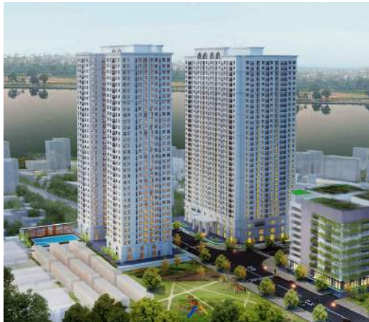
Dự án chung cư ECO LAKE 32 Đại Từ.
