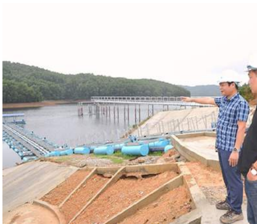
Dự án xây dựng hệ thống cấp nước sạch tại địa bàn tỉnh Quảng Nam.
