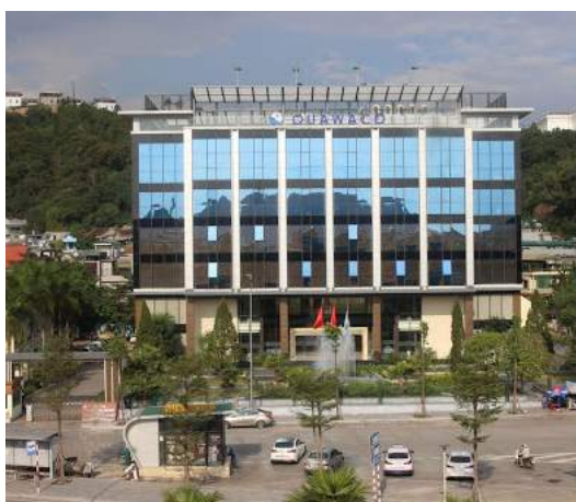
Nhà máy nước sạch Quảng Ninh.
