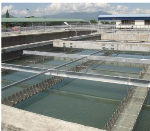
Dự án xây dựng hệ thống cấp nước sạch tại địa bàn tỉnh Thái Nguyên.
